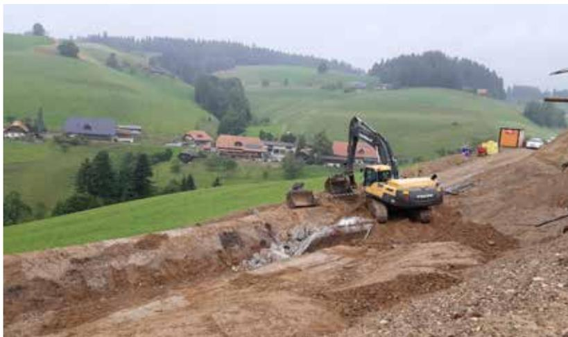
*Kurz vor «Schluss» darf auch der Betonbau vom Zeigerstand abgebrochen und entsorgt werden.*
