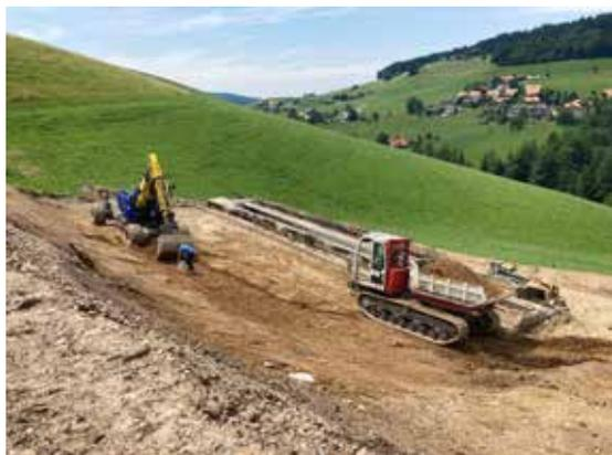
Fortlaufend wird durch die Geologin der Verschmutzungsgrad mittels Röntgenstrahlen-Messgerät bestimmt und angezeichnet, damit der Baggerführer und Dumperfahrer den Aushub und die Zwischenlagerung nach Materialklasse ausführen können.
