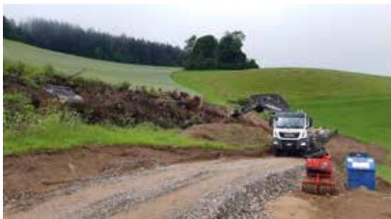
Direkte Abfuhr mit Lastwagen des Materials für die Bodenwaschanlage (Einschussbereiche)
