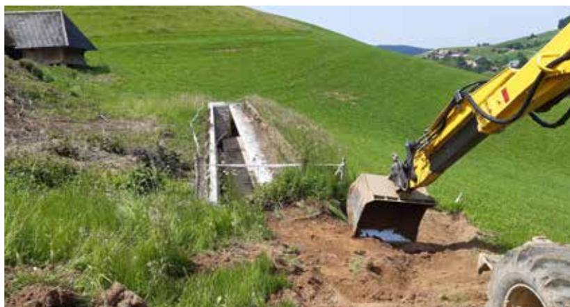
Installation Baupiste und Aushub belastetes Bodenmaterial bis zum Zeigerstand
