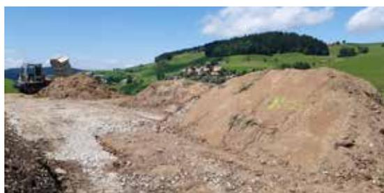
Haufwerke auf Zwischenlagerplatz je nach Verschmutzungsgrad (Entsorgungstyp)
