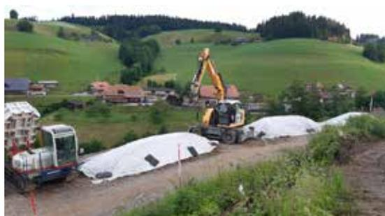
Gedeckte Haufwerke bis chemische Analyse und Genehmigung von Deponie vorliegt.
