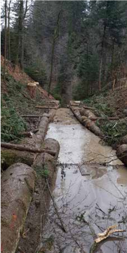
Saniert in den Kalenderwochen 13 und 14
