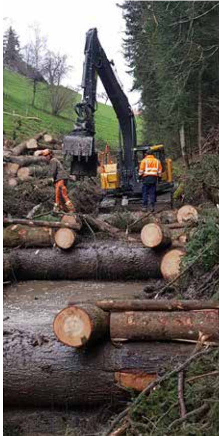
Bagger von «Gerber macht's»
